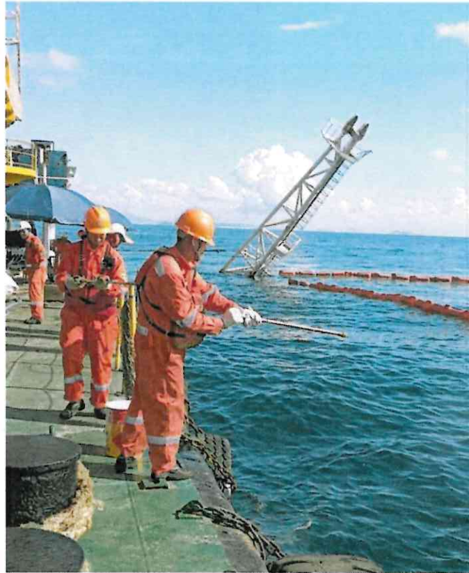
图 13. 施工人员向海面上喷洒消油剂
